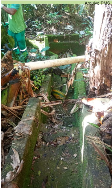
Limpeza de caixas, vala e canal da Rua 1, no Santa Maria
