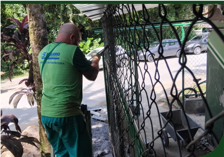
Instalação de telas no alambrado na sede da Prefeitura Regional
