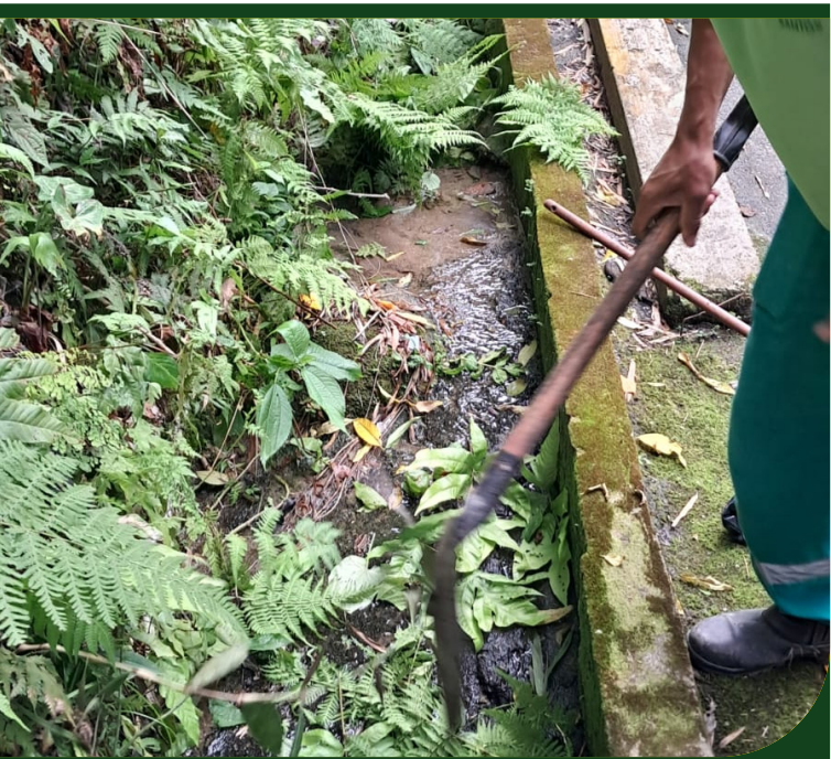
Limpeza de córrego e canaleta na Carlos Alberto Curado, no Morro José Menino
