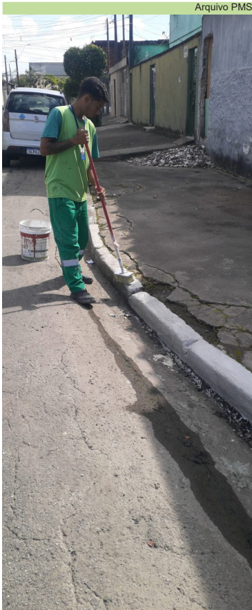
Pintura de guias e postes das ruas Antônio Ludgero dos Santos e Romeu La Scala
