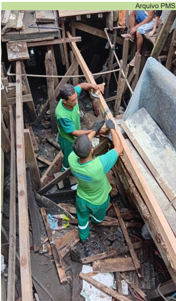
Manutenção da passarela do Caminho São Sebastião, no Rádio Clube
