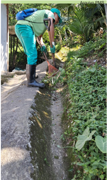
Limpeza de caixas, córrego e vala na Rua 6, no Morro José Menino
