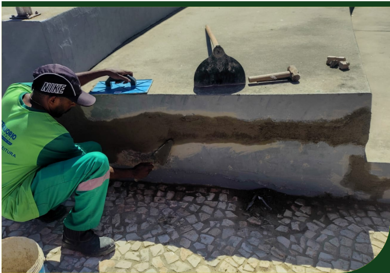
Reparo nas muretas ao lado do Monumento Tomie Ohtake
