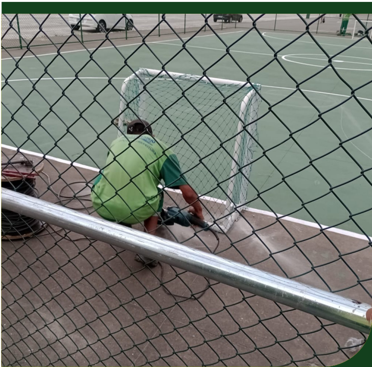
Fixação das traves de gol caixote na quadra esportiva da Escola Total
