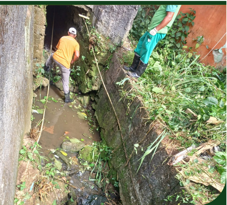
Limpeza de vala e escada hidráulica na Rua 1, no Morro Santa Maria
