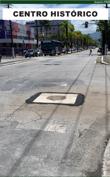
CENTRO HISTÓRICO Troca de laje com poço de visita na Cons. Nébias com a Campos Sales
