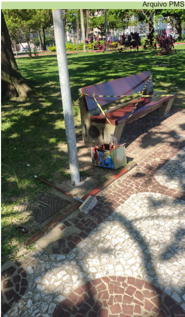
Serviço de pintura dos bancos na orla, no Canal 2
