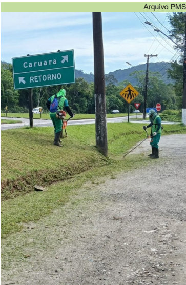
Poda, limpeza e varrição pelas ruas do Caruara
