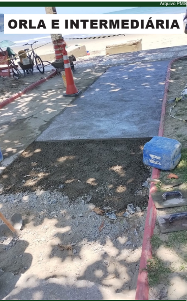
ORLA E INTERMEDIÁRIA Reparos na calçada da alameda na orla da praia, no Canal 5
