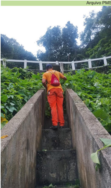
Limpeza de caixas e hidráulica na Av. Pref. José Gomes, na Caneleira
