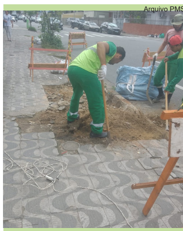
Reparos em calçada danificada por raízes de árvore na Rua Bento de Abreu
