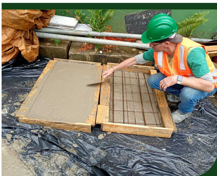
Produção de novas tampas de concreto no Morro Nova Cintra
