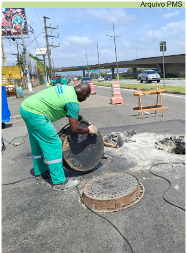
Troca de poços de visita na Avenida Martins Fontes
