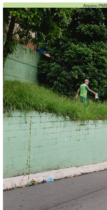
Corte de mato na área externa do Colégio João Octávio, no Morro São Bento
