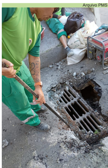
Troca de grelha na Rua Beco do Asilo, na Vila São Bento
