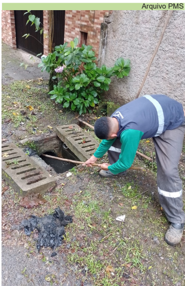
Limpeza de caixas de drenagem na Rua das Palmas
