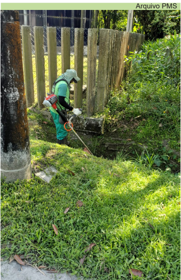
Roçada e limpeza na Rua Tupy, no Caruara
