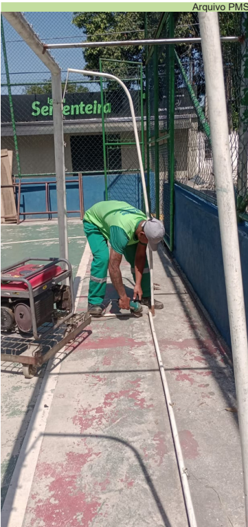
Reparos nas traves e no alambrado da quadra esportiva em praça da Vila São Jorge
