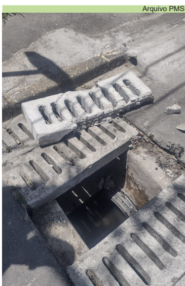
Troca de grelha na Rua Maria dos Reis, no Nova Cintra
