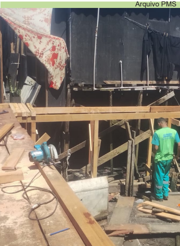
Manutenção da passarela do Caminho São Sebastião, no Rádio Clube
