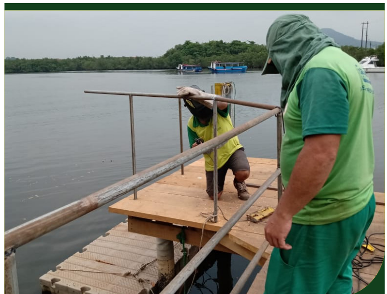
Continuação da instalação de guarda-corpo do píer de acesso à Ilha Diana
