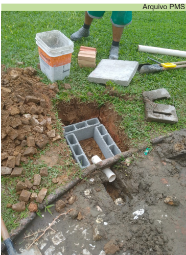
Construção de caixa de drenagem na praia, perto do Posto 7
