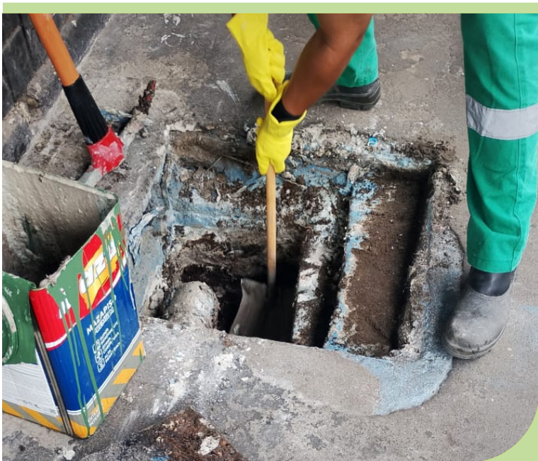
Desentupimento de caixa de esgoto no Posto Avançado de Zeladoria no Rádio Clube
