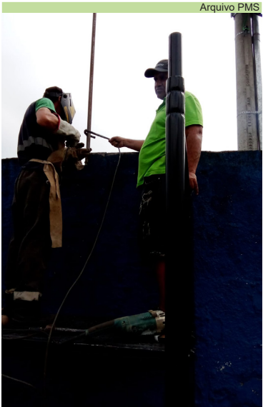
Montagem parcial do alambrado sobre o muro da UME Pedro Crescenti
