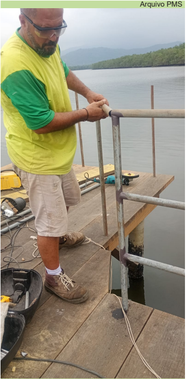
Instalação de guarda-corpo no píer de acesso à Ilha Diana
