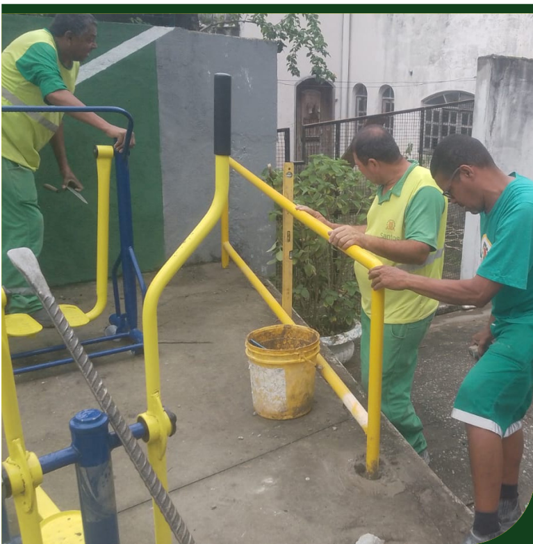
Instalação de grade de proteção na academia ao ar livre na Rua Engenheiro José Garcia da Silveira
