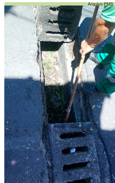
Limpeza de grelhas na Rua São Sérgio, no São Bento
