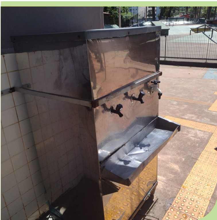
Manutenção no bebedouro e substituição de torneira na Lagoa da Saudade, no Nova Cintra
