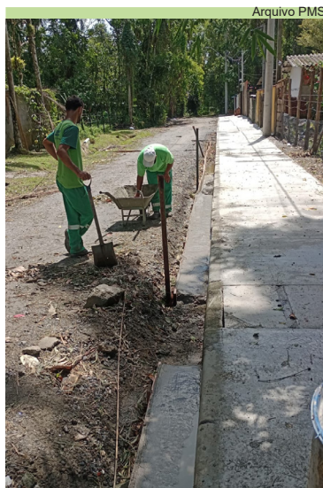
Continuação de construção de sarjeta na Rua Vila Rica
