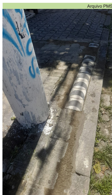
Reparos em calçada, esquina da Evaristo da Veiga com Teixeira de Freitas
