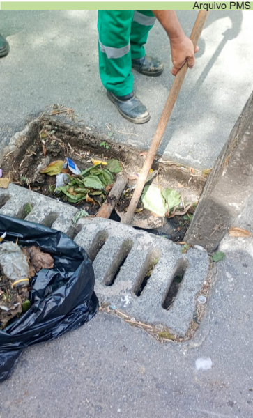
Limpeza de caixas e grelhas no Caminho Central, no Morro Saboó
