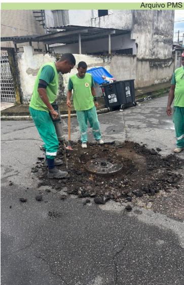
Troca e nivelamento de poço de visita na Rua Walter Belian, na Areia Branca
