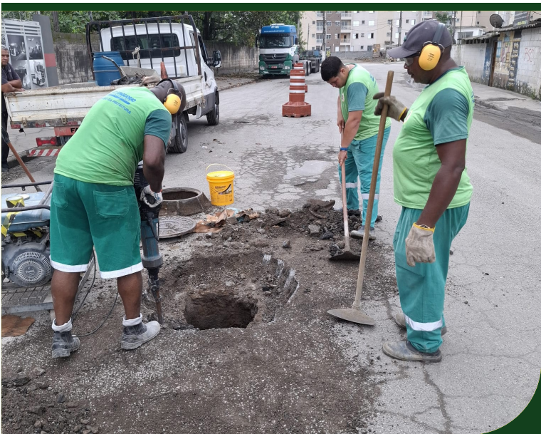
Troca da tampa de poço de visita na Rua Doutor Zelnor de Paiva Magalhães
