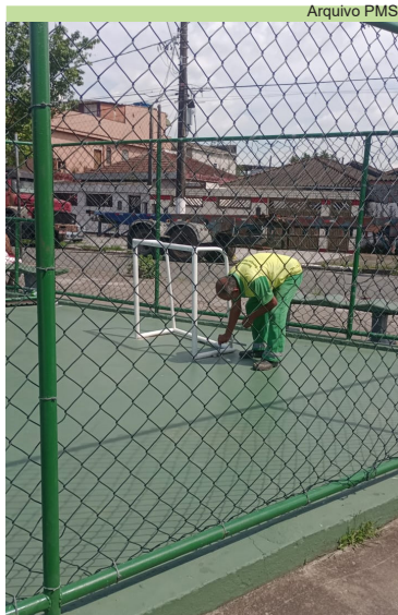
Amarração e esticamento de telas no alambrado de playground
