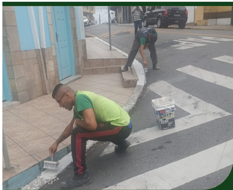
Pintura de guias e postes na Avenida Nossa Senhora de Assunção, no São Bento
