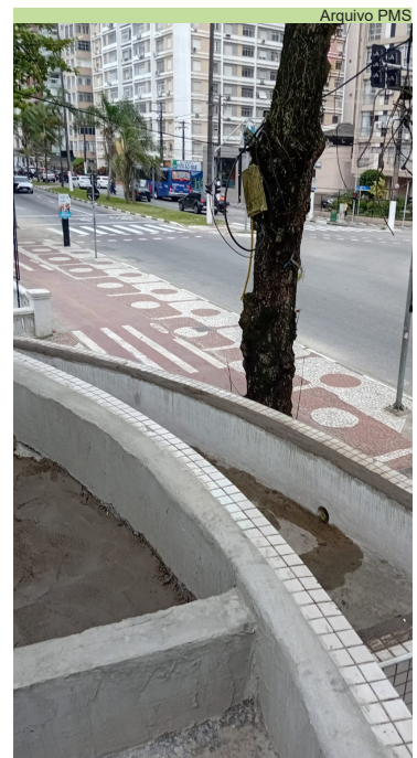
Reparos na área externa do banheiro público, na orla do Canal 5
