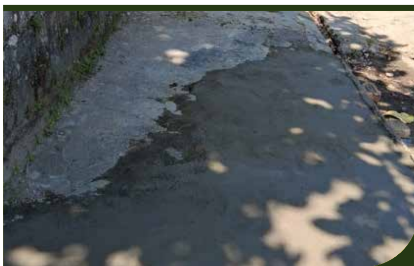
Conserto de calçada na Rua Alfredo Albertini, no Marapé
