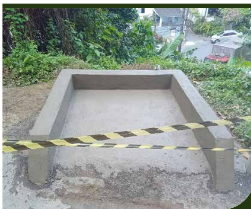
Construção de baia na Rua 15 com Rua Amália Rodrigues, Morro Nova Cintra
