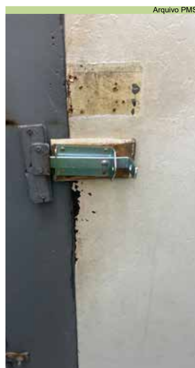
Troca de dobradiças e ferrolho no banheiro feminino no quiosque do Canal 4
