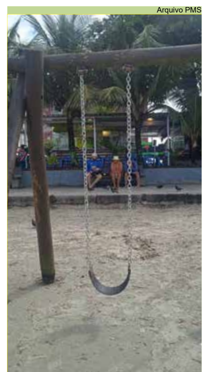
Instalação de dois balanços no playground na orla da praia, no Canal 6
