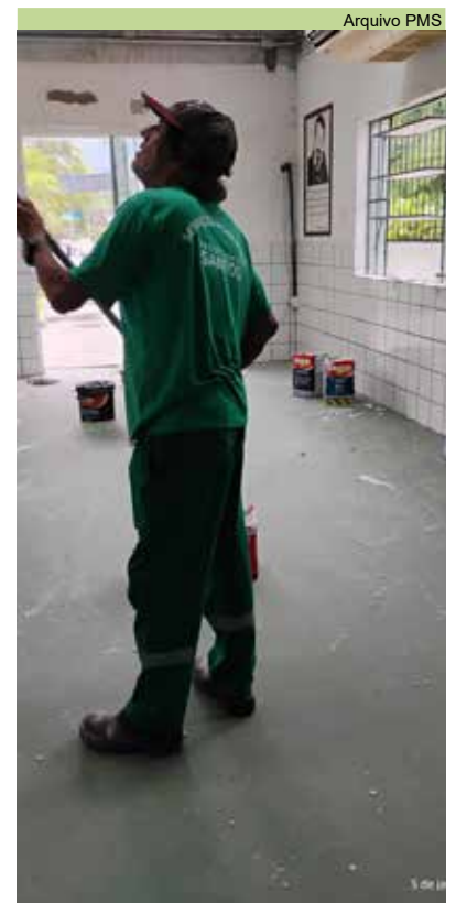
Aplicação de massa corrida e pintura da sala da biblioteca no Caruara
