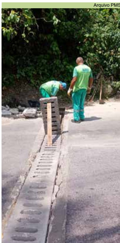
Limpeza de grelhas na Rua 01, Morro Nova Cintra
