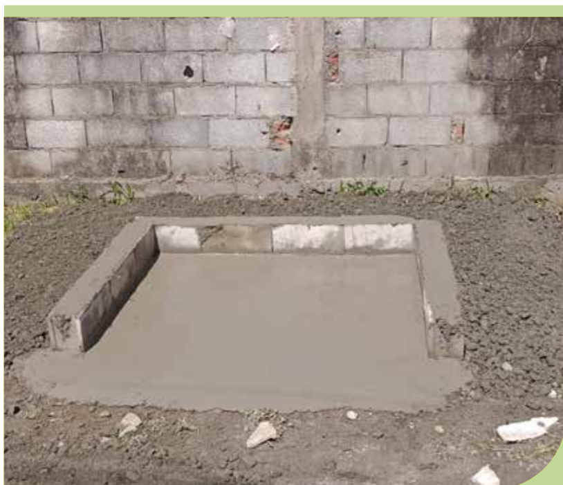
Construção de baia para colocação de contentor de lixo na esquina das ruas 6 com Xavantes
