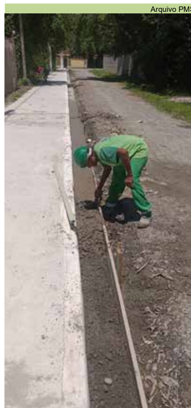
Concretagem em sarjeta na Rua Vila Rica, no Caruara
