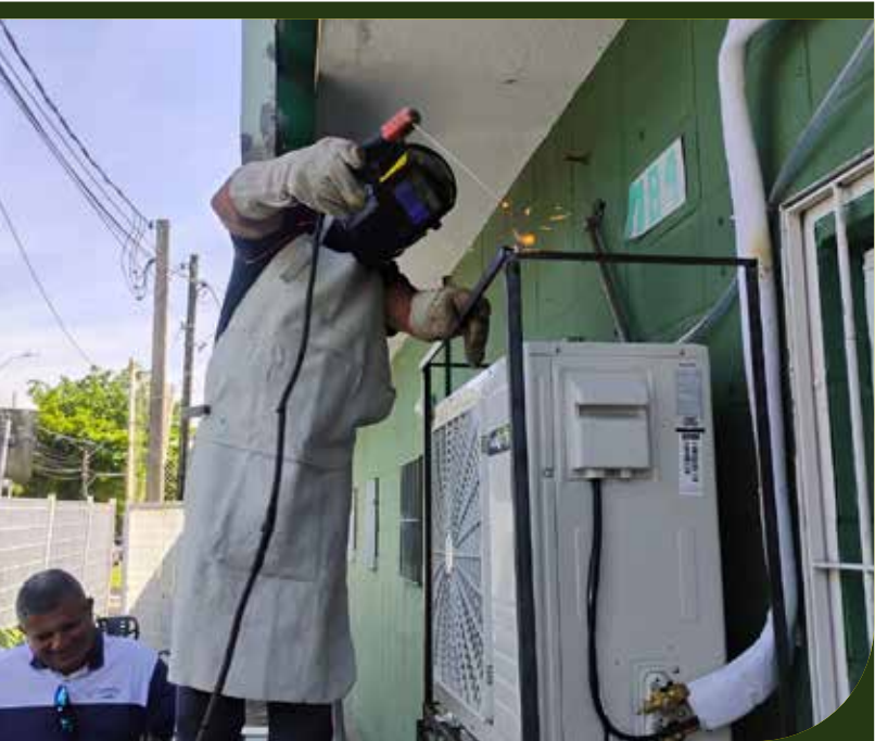
Instalação de grade de proteção no aparelho de ar-condicionado da Policlínica do Castelo
