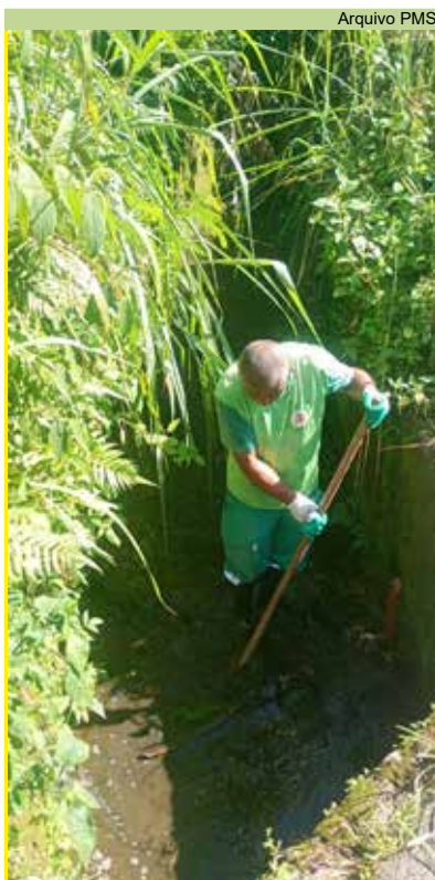
Limpeza no sistema de drenagem na Avenida Brasil, no Morro Nova Cintra
