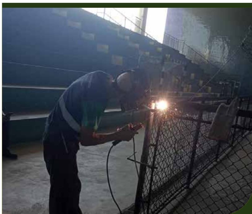
Reparos no alambrado na quadra esportiva do Ginásio Poliesportivo M.Nascimento Júnior, no Santa Maria
