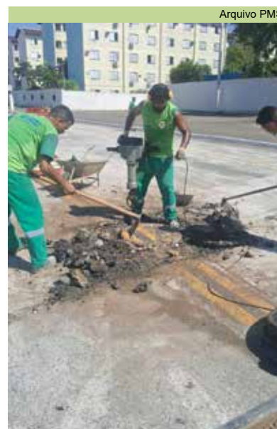
Troca da tampa do poço de visita na Avenida Afonso Schmidt, no Castelo
