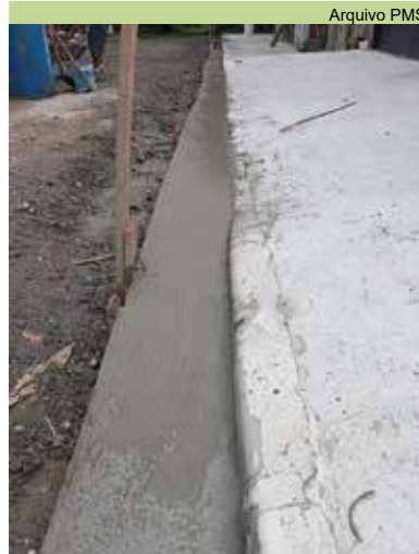
Concretagem de sarjeta na Rua Vila Rica, no Caruara
