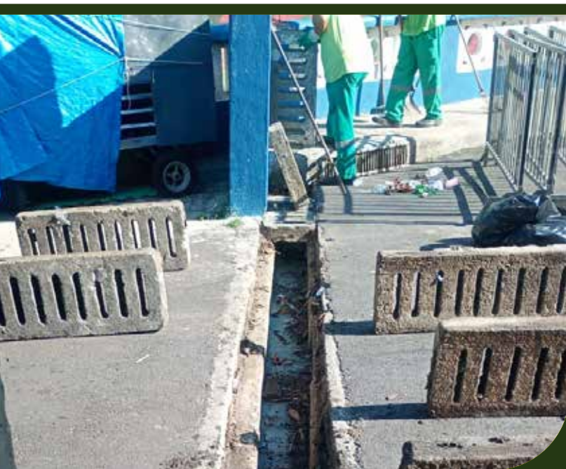
Limpeza de grelhas do lado da GRES Unidos dos Morros, na Avenida Prefeito. Dr. Antônio Manoel de Carvalho, Morro Nova Cintra
