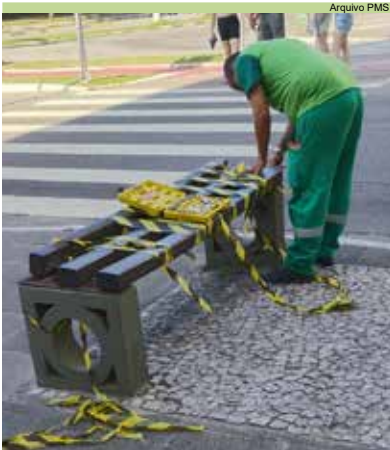
Retirada de bancos quebrados na Avenida Ana Costa, no Gonzaga
