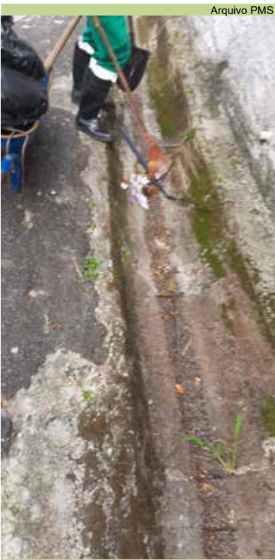
Limpeza de vala e canaleta na Rua Carlos Alberto Curado, Morro José Menino
