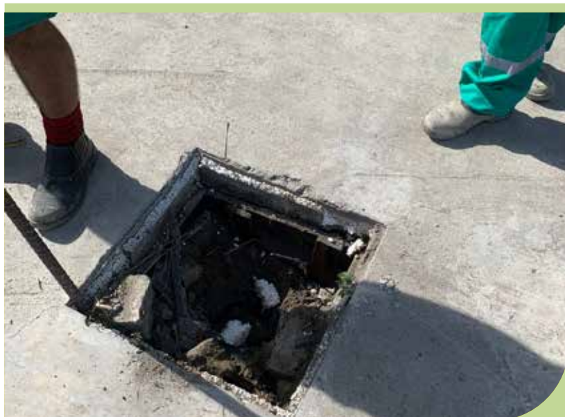
Troca de tampa de caixa de passagem na rua Tuyuti, nº 96, no Centro
