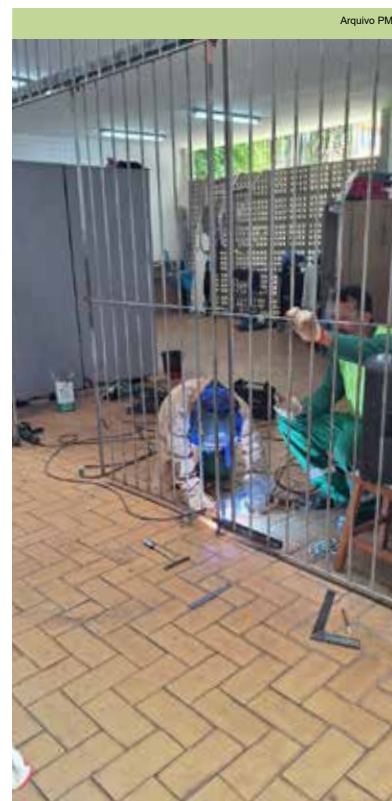
Reparos no portão da piscina do Ginásio Rebouças
