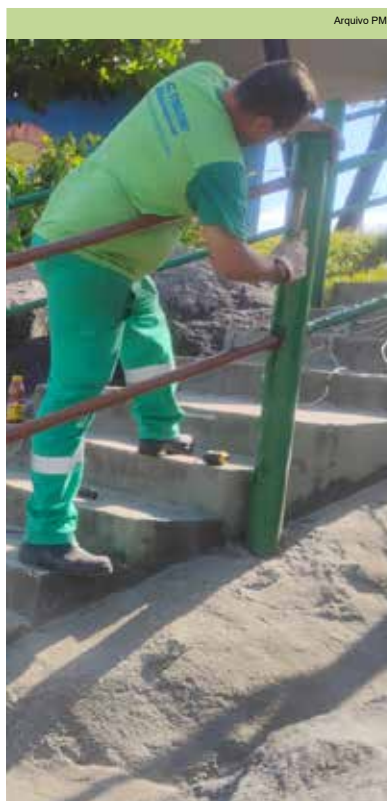
Manutenção na barra de apoio da escada da Escola de Surfe, no Emissário Submarino
