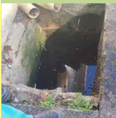
Limpeza de caixas na Rua dos Inválidos no Morro Nova Cintra
