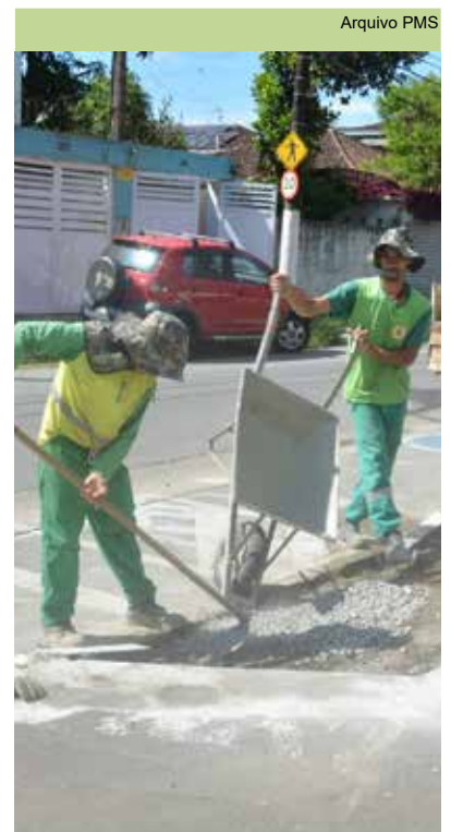
Reparos na calçada na Rua João Fraccaroli, no Bom Retiro
