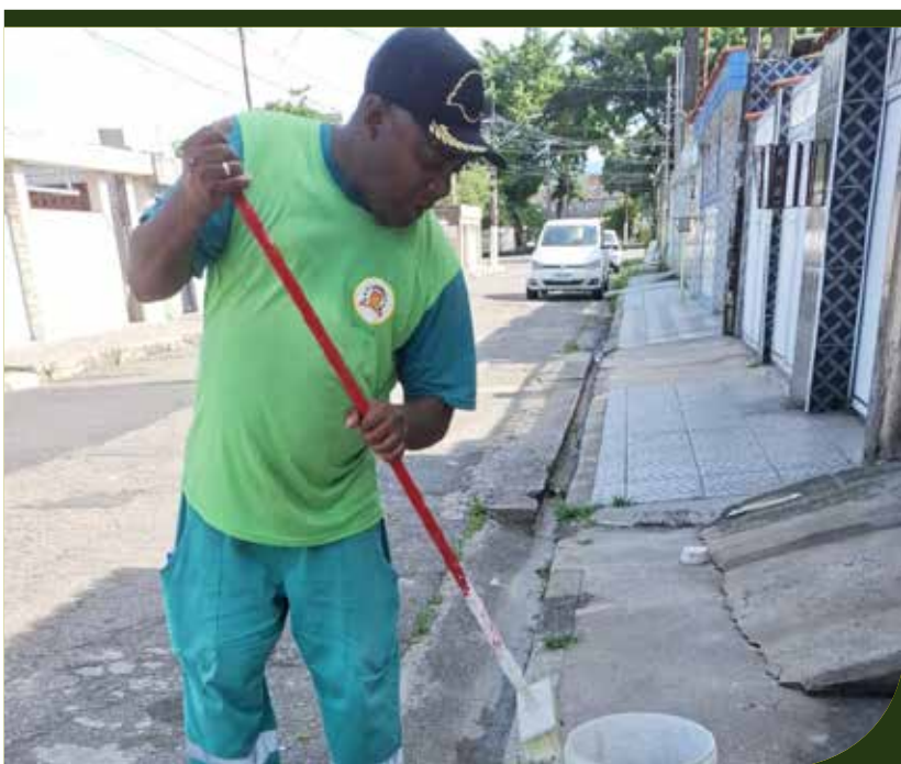
Pintura de guias e postes na Rua Iracema Rocha Manzione, no Castelo
