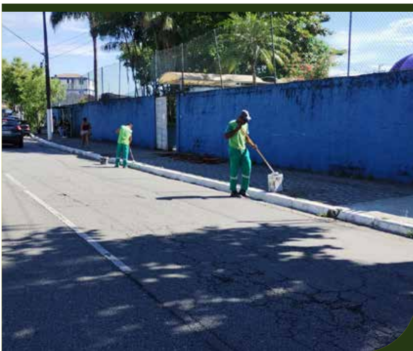
Pintura de guias e sarjetas na Avenida Aprovada, em frente ao número 927, no Rádio Clube
