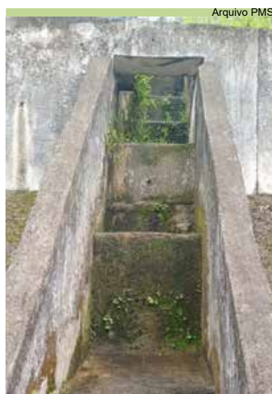
Limpeza de canaletas e escada hidráulica no Morro Marapé
