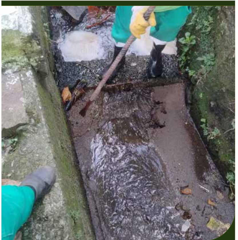
Limpeza de caixas e vala na Rua Coronel Galhardo e a Avenida Brasil, no Nova Cintra
