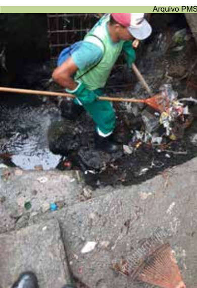
Limpeza de caixas e vala na Vila São Bento
