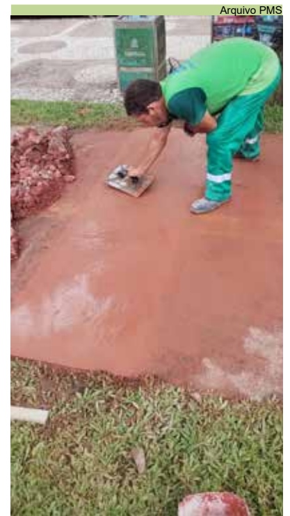
Reparo no ciclovia na Avenida Bartolomeu de Gusmão, em frente ao Posto 6
