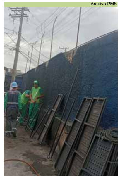
Montagem parcial do alamedado sobre o muro da UME Pedro Crescenti, no Rádio Clube
