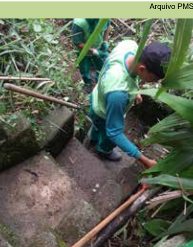
Limpeza de canaletas e escada hidráulica no Caminho dos Teixeiras
