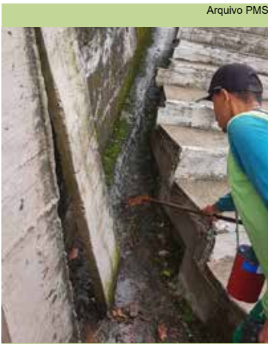
Limpeza de grelhas e canaleta na Rua Santa Inês, no Morro São Bento
