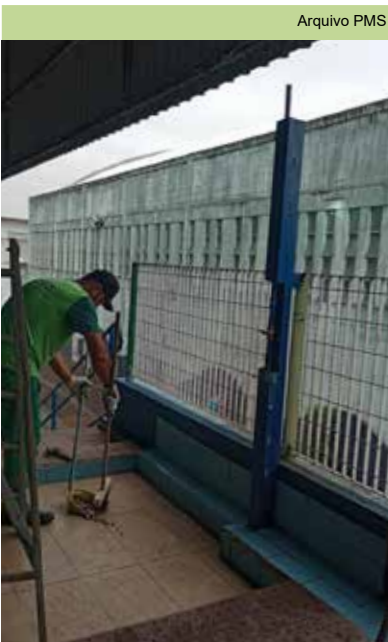
Manutenção na estrutura metálica da base do chuveiro da piscina no Centro
