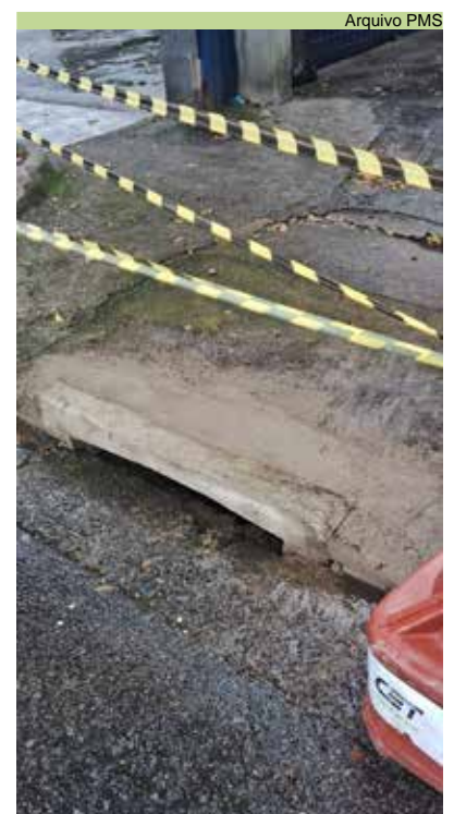
Reposição de boca de sapo na Avenida Pedro Lessa, Aparecida
