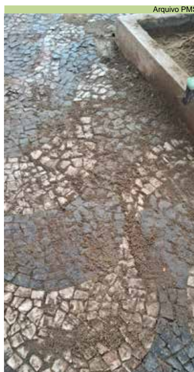
Reparo em calçada com piso mosaico na Rua Carvalho de Mendonça
