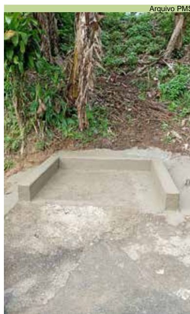
Construção de base para contentor de lixo no Nova Cintra
