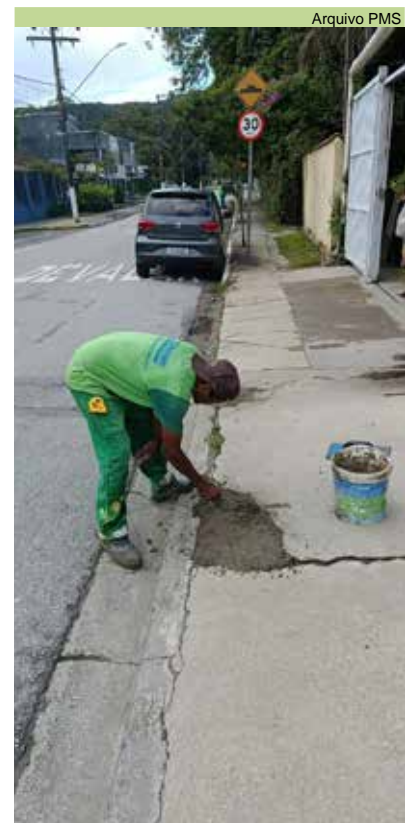
Reparo em calçada no bairro Caruara
