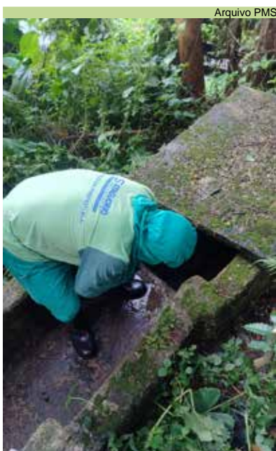
Limpeza de escada hidráulica na Rua Nossa Senhora de Lourdes
