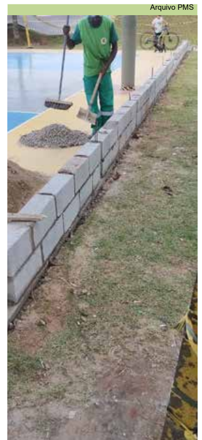
Construção de mureta para o alambrado no Emissário
