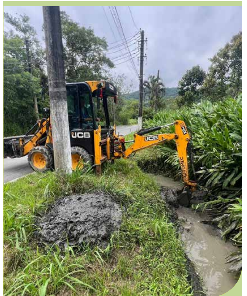
Limpeza de vala e nivelamento da Rua Principal, no Monte Cabrão
