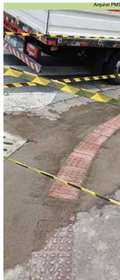
Reparos em rampa de acessibilidade na Vila Belmiro
