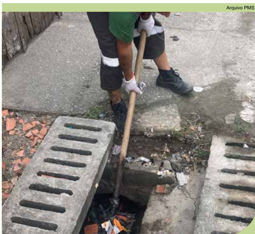
Limpeza de valas e caixa de passagem na Rua Trusilva, no Caruara
