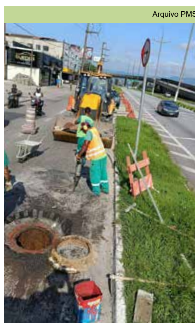
Substituição da tampa de poço de visita na Avenida Martins Fontes, no Saboó
