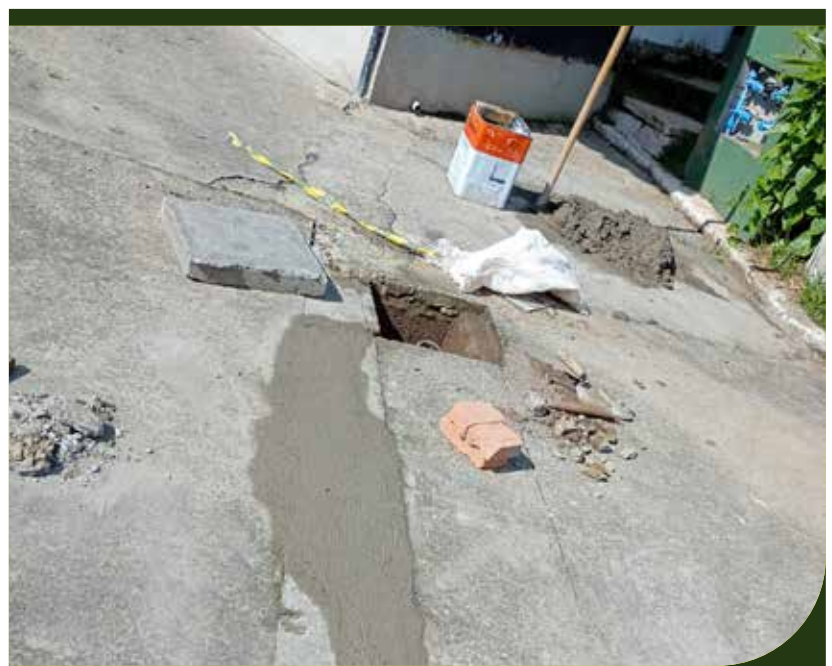
Instalação de tampas de concreto no entorno da Praça Guadalajara
