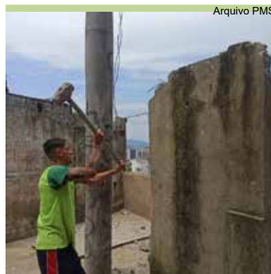
Demolição de imóvel da Rua Santa Mercedes, no São Bento
