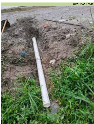
Reparo em encanamento de água pluvial na Rua Vila Rica
