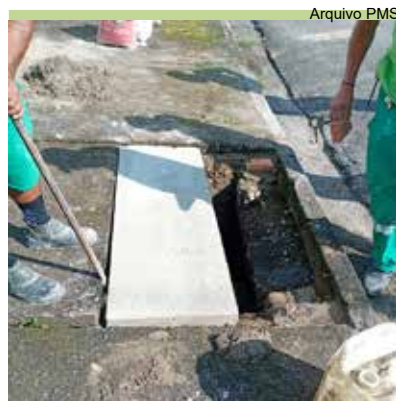
Retirada de tampa danificada na Rua Guedes Pereira, no Nova Cintra
