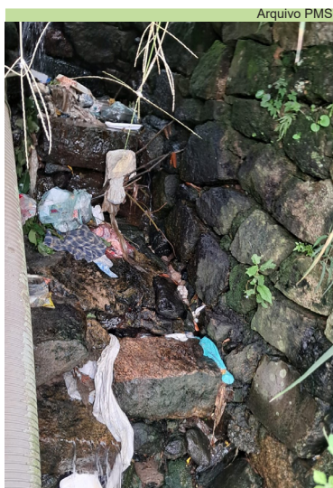
Limpeza de córrego na Rua 5, no Morro Pacheco
