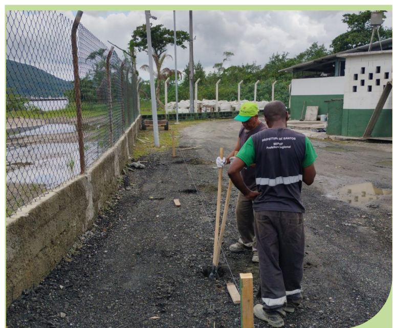
Nivelamento e escavação de brocas para o alambrado, na Cortec
