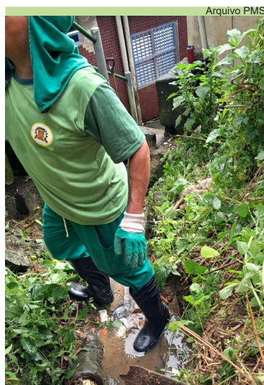
Limpeza de córrego e escada hidráulica na Rua 12, no Morro Pacheco
