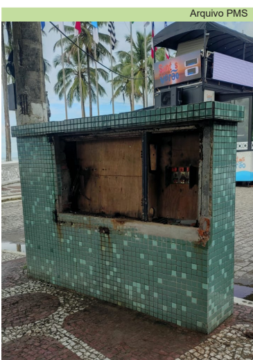
Colocação das portas nas caixas de eletricidade na Praça das Bandeiras
