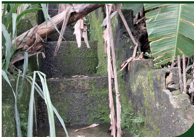
Serviço de limpeza de escada hidráulica na Rua 5, no Pacheco
