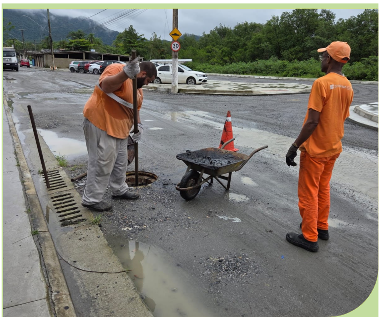
Limpeza das caixas e poço de visita na Rua Andrade Soares, no Caruara
