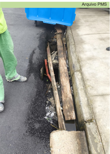
Colocação de bocas de lobo na Rua José do Patrocínio, no Macuco
