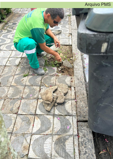
Reparo em calçada na Rua Maestro Heitor Villa Lobos, na Ponta da Praia
