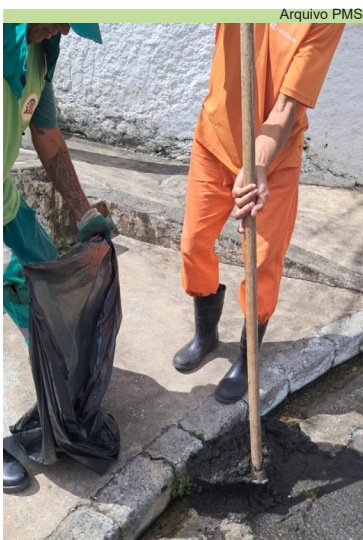
Limpeza de grelhas na Rua Brig. Nilton Braga, no Morro Penha
