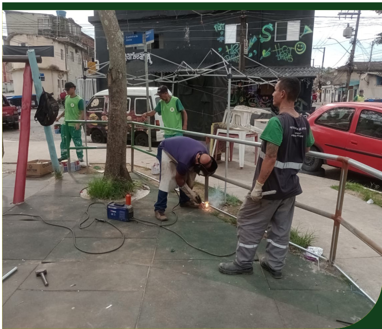
Finalização da montagem , soldagem e pintura com zarcão na alambrado do playground no Caminho da Capela
