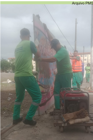
Recolocação e soldagem de dois portões do terreno, ao lado dos blocos A e B, no Centro
