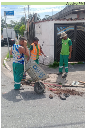
Bocas de lobo no trecho entre as ruas Maria Patrícia e Adriano Tourinho recebem manutenção
