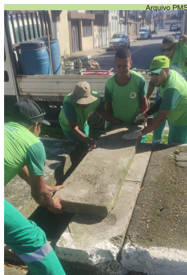
Tampa de concreto é instalada na Avenida Afonso Schmidt, 838, no Castelo
