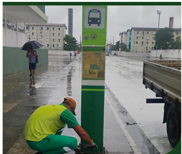
Concluída reposição do ponto de ônibus na Avenida Afonso Schmidt, próximo ao Sambódromo
