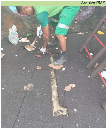
Piso do playground de praça no Morro Santa Maria recebeu ações de reparo
