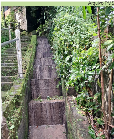
Concluída limpeza de caixa e hidráulica no Caminho dos Trinta, no Morro Saboó
