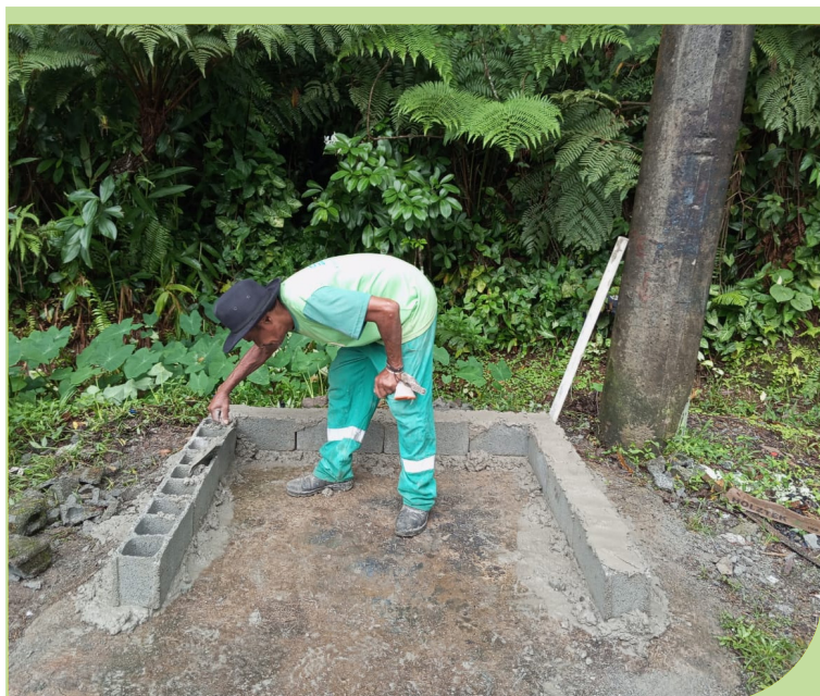
Instalação de bases para contentores de lixo na Rua Marginal, no Caruara
