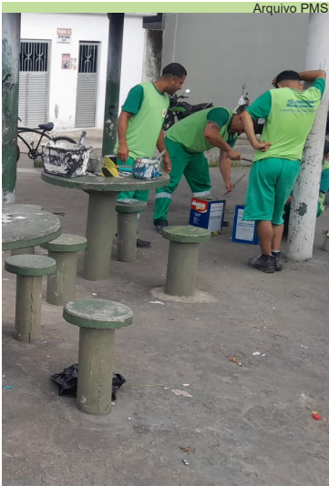
Pintura de mesas, bancos e guias na Praça José Lamacchia, no Rádio Clube
