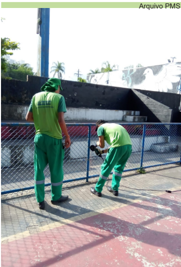
Reparos no alambrado da quadra esportiva coberta da Praça da Paz Celestial
