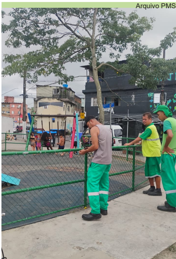
Serviços de reparo no alambrado do playground do caminho da Capela
