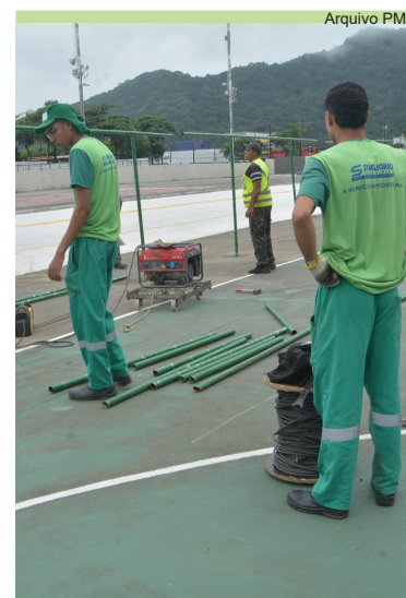
Recolocação de alambrado na quadra poliesportiva do Sambódromo, no Castelo
