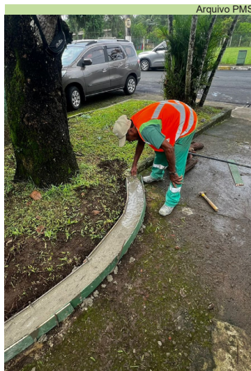
Monte Cabrão: concretagem do cordonel do jardim, na Policlínica
