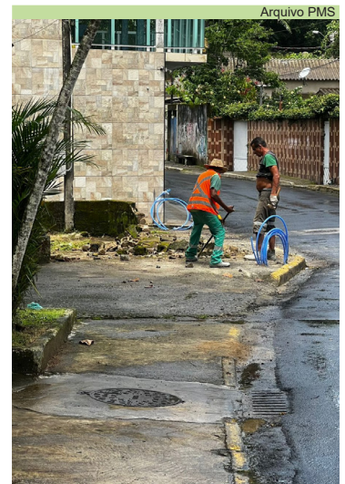
Manutenção de calçada na Rua Principal, no Monte Cabrão
