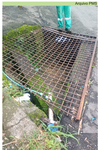
Limpeza de caixa na Rua Central, no Morro Saboó
