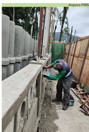
Manutenção em mureta da sede da Coordenadoria Técnica (Cortec)
