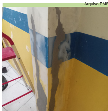
Concretagem em pilar da sede dos Correios, no Morro São Bento
