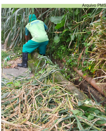
Limpeza de canaletas e caixas na Rua 08, no Morro J. Menino
