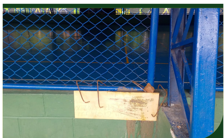
Manutenção na mureta da quadra poliesportiva Milton Ruiz, no Morro São Bento
