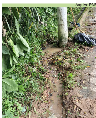
Limpeza de córrego na Rua 03, no Morro José Menino
