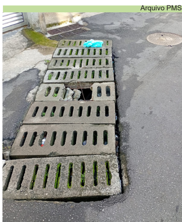
Troca de grelha na Rua 9, no Morro Santa Maria
