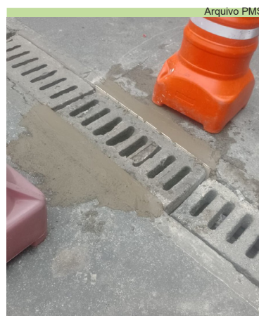
Serviço de troca de grelha na Rua 1, subida do Cabo
