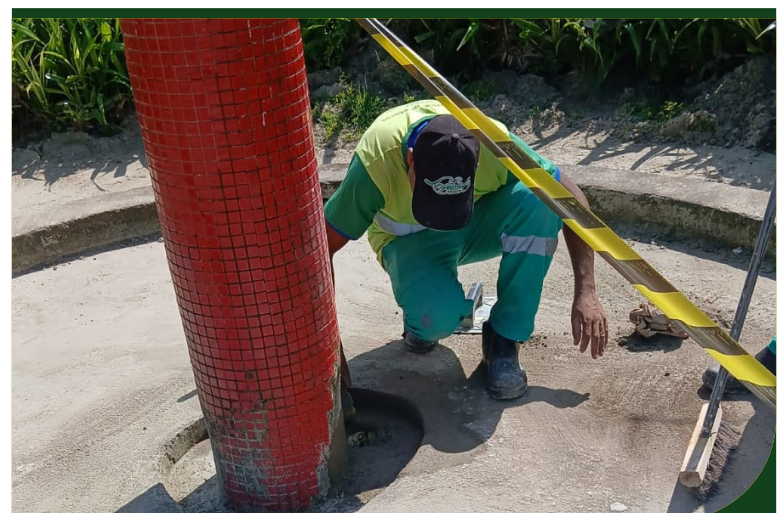
Reparo no piso do chuveirinho 35 frente a Av. Bartolomeu de Gusmão, entre o canal quatro e o cinco
