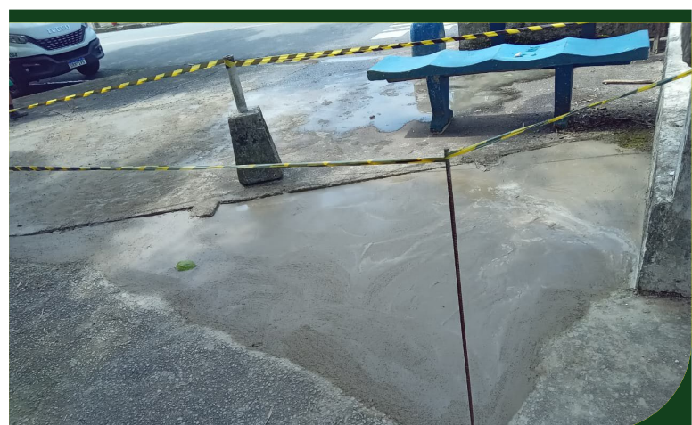
Reforma de calçada na Rua Manoel Pereira, esquina com Avenida Santista, no Morro Nova Cintra
