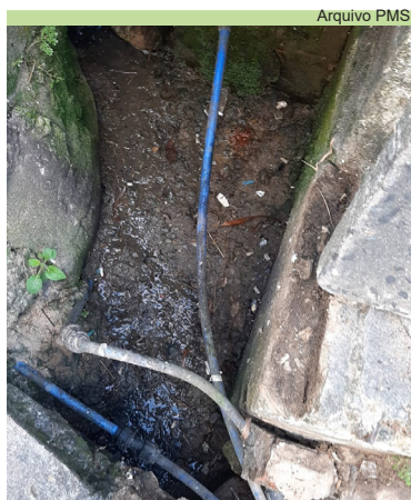
Limpeza de caixas na Rua Santa Marina, no Morro Fontana
