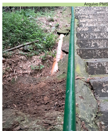
Limpeza de canaletas no Caminho dos Teixeira
