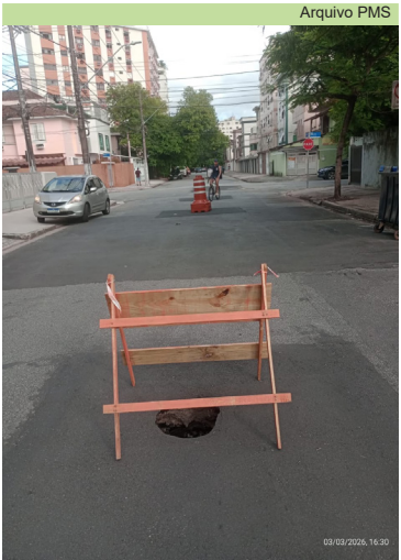
Manutenção asfáltica na Rua Nabuco de Araújo, no Embaré
