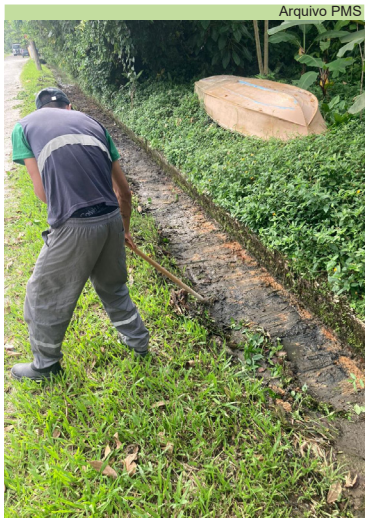
Serviço de limpeza de vala na Rua Tamoios, no Caruara
