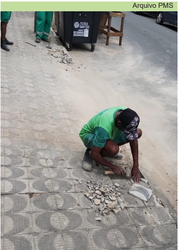
Reparo na calçada: Rua Guedes Coelho com Avenida Senador Feijó
