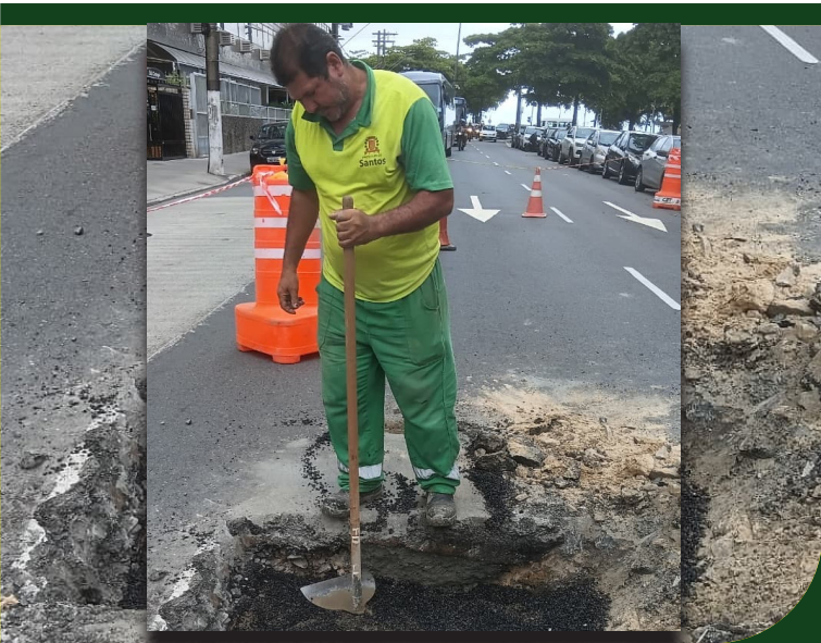
Manutenção asfáltica na Avenida Senador Pinheiro Machado, em frente ao número 1023, José Menino
