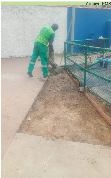
Concretagem em torno do playground do Caminho da Capela
