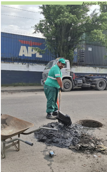
Limpeza no sistema de drenagem da Av. Vereador Alfredo das Neves
