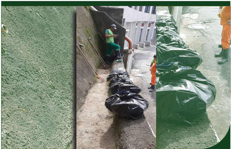
Serviço de limpeza de canaleta e escada hidráulica na Rua Nossa Senhora do Monte Serrat
