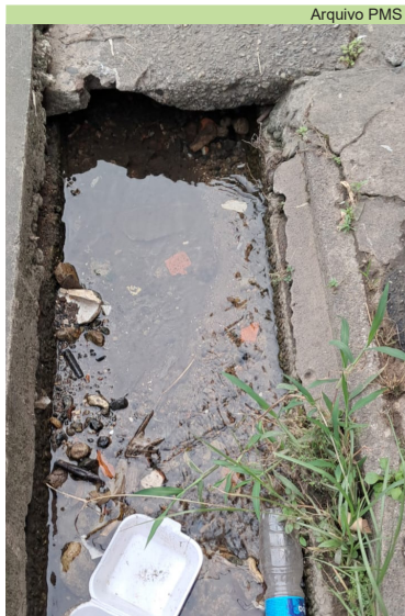
Limpeza de canaleta na Rua Rubião Júnior, no Morro Fontana
