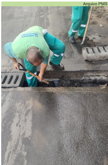
Limpeza de grelhas na Rua 01, no Morro Nova Cintra
