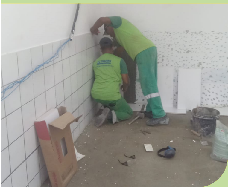
Instalação e aplicação de rejunte no revestimento cerâmico na Biblioteca Municipal Plínio Marcos
