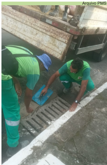
Manutenção em bocas de lobo: Amadeo Barbiellini, João Fraccaroli e Engenheiro Antônio Freire
