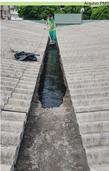
Serviço de limpeza de calhas na Policlínica do Valongo, no Saboó
