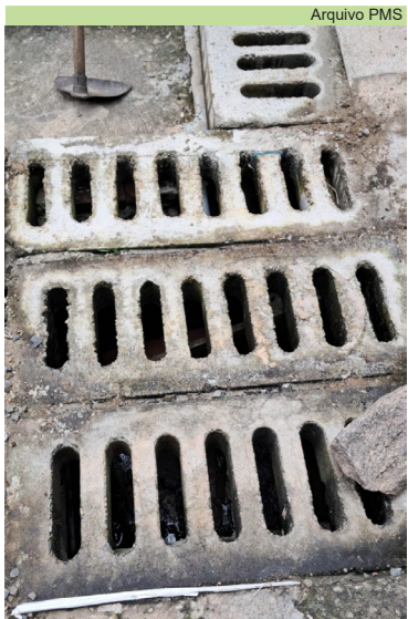
Limpeza de grelhas na Rua Santa Clara, no Morro São Bento
