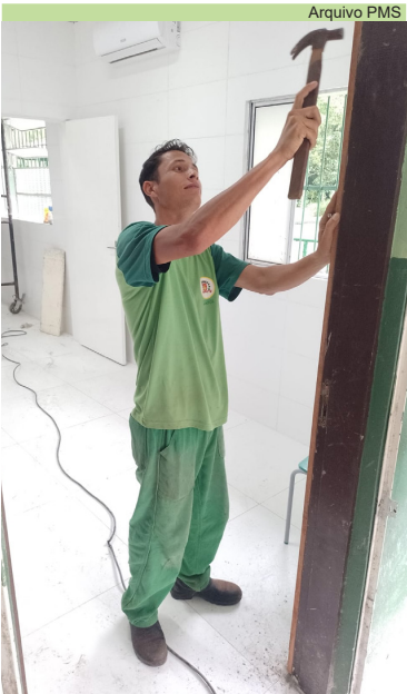
Colocação de batentes de porta na Clínica Veterinária
