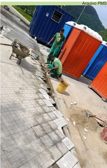
Execução de serviços de colocação de piso na Arena Caneleira
