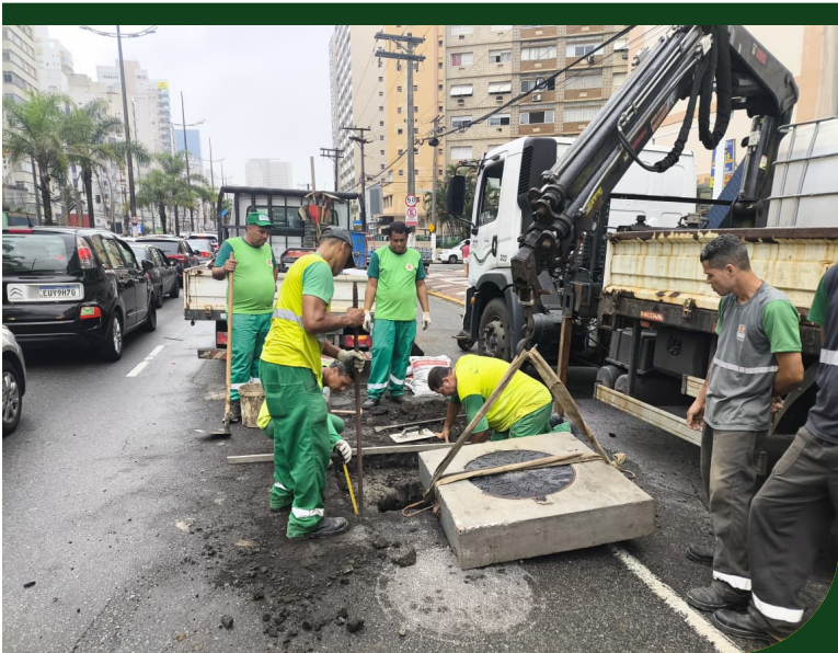
Troca de laje do poço de visita na Avenida Presidente Wilson, em frente ao número 2077, no José Menino
