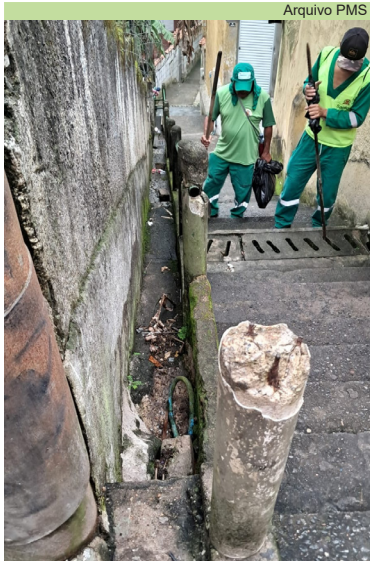
Limpeza de caixa, canaleta e escada hidráulica na Rua São Lucas, no Morro São Bento
