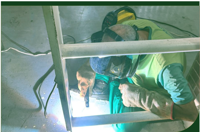
Soldagem do portão da quadra poliesportiva na Vila Criativa da Vila Progresso, no Morro Marapé
