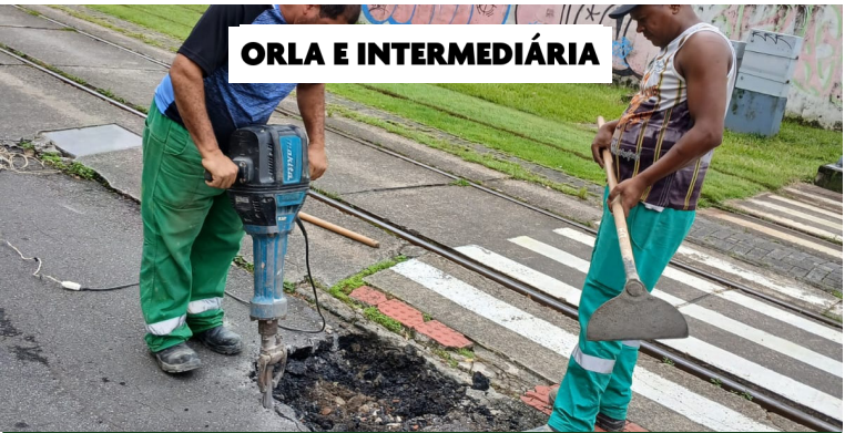
Manutenção asfáltica na Rua Marquês de São Vicente, no Campo Grande
