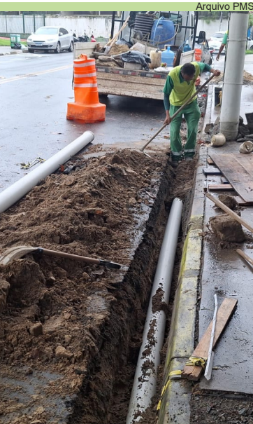
Continuação da instalação da rede drenagem na Avenida Afonso Pena, no Estuário
