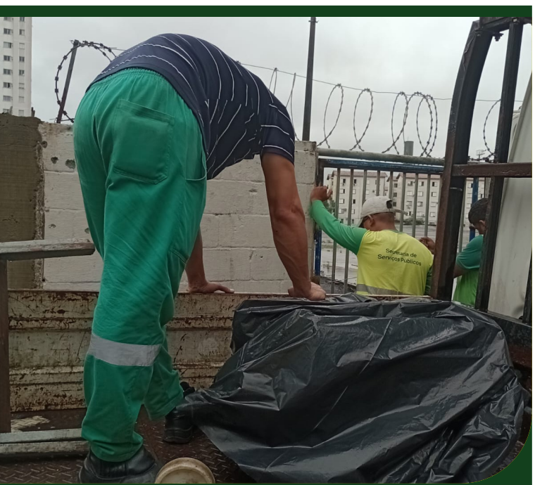
Soldagem e fechamento do portão do terreno entre os blocos A e B, no Centro Cultural, no Sambódromo
