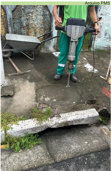
Instalação de poço de visita e tampa de concreto na Rua Carlos Caldeira, no Santa Maria
