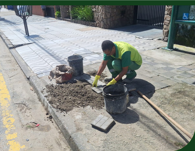
Conserto de calçada no ponto de ônibus a Avenida Afonso Pena, próximo ao número 687
