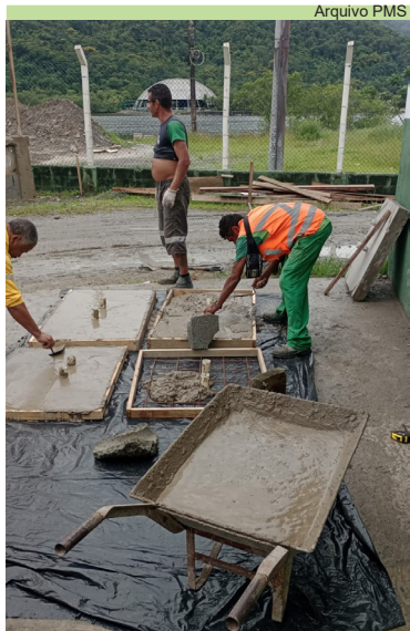
Concretagem de tampas para utilização em caixas de passagem
