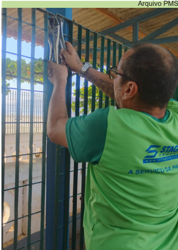
Retirada das grades da cancha de bocha no Emissário Submarino
