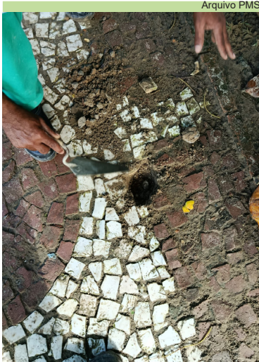
Reparos no piso mosaico em frente à Avenida Presidente Wilson, 150, no Canal 1
