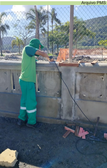
Continuação da construção da mureta da Coordenadoria Técnica
