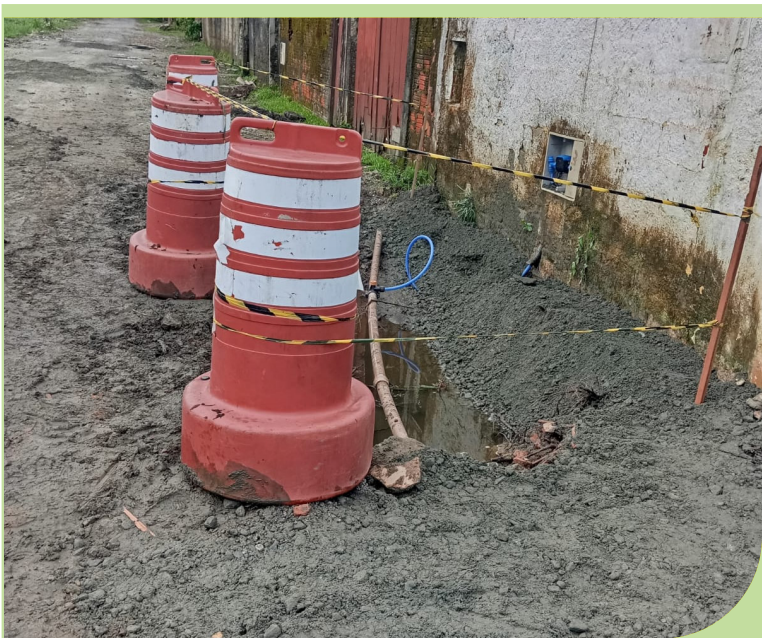
Retirada de tronco de árvore para a instalação de manilhas na Rua das Palmas, no Quilombo
