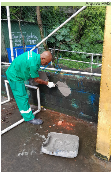
Reparos nas muretas quadra poliesportiva na Rua 2, no Ilhéu Alto
