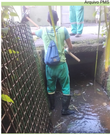
Limpeza de caixas e do canal na Avenida Brasil, no Morro Nova Cintra
