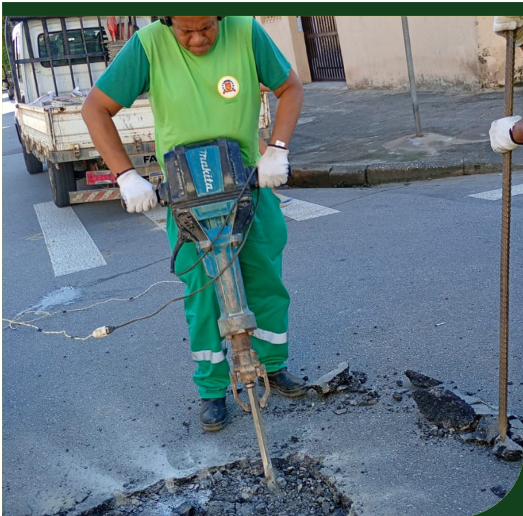
Manutenção no entorno do poço de visita na Rua Oswaldo Cochrane, em frente ao número 314, no Embaré
