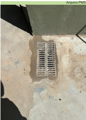
Instalação de ralo e rampa de acessibilidade no Posto Avançado de Zeladoria (PAZ), na Ponta da Praia
