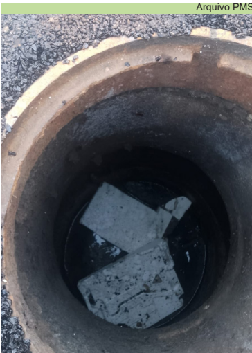
Limpeza de poço de visita na Rua Oswaldo Cruz, em frente ao número 437, no Embaré
