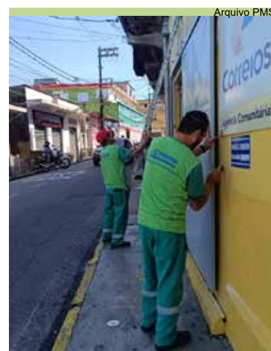
Continuação da pintura na sede dos Correios do Largo São Bento
