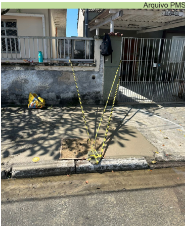
Reparo na calçada após remoção de árvore na Rua Roberto de Molina Cintra, 24
