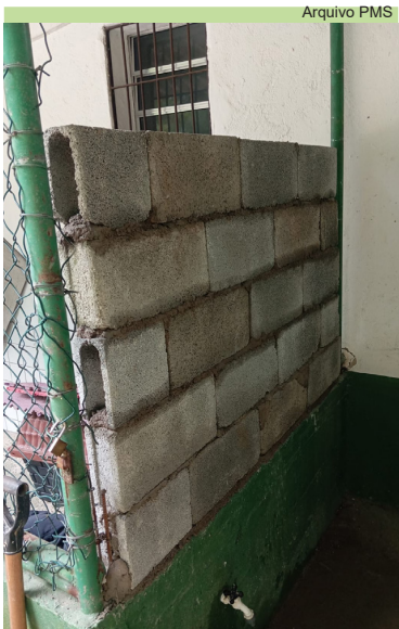
Construção de muro na base de apoio no Monte Cabrão
