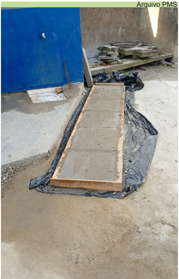
Produção de tampas de concreto
