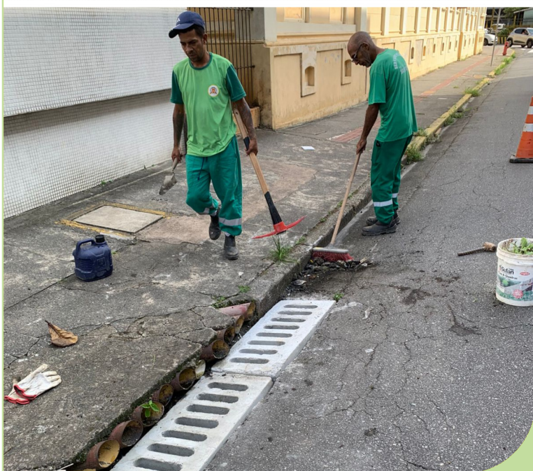
Troca de grelha da boca de lobo na Rua Andrade Neves, em frente ao número 15, no Centro
