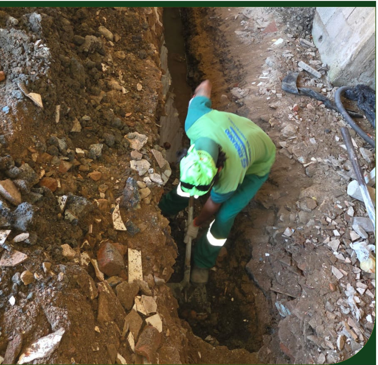
Continuação da instalação de ramal de drenagem na Travessa Francisco Lourenço Gomes, na Alemoa
