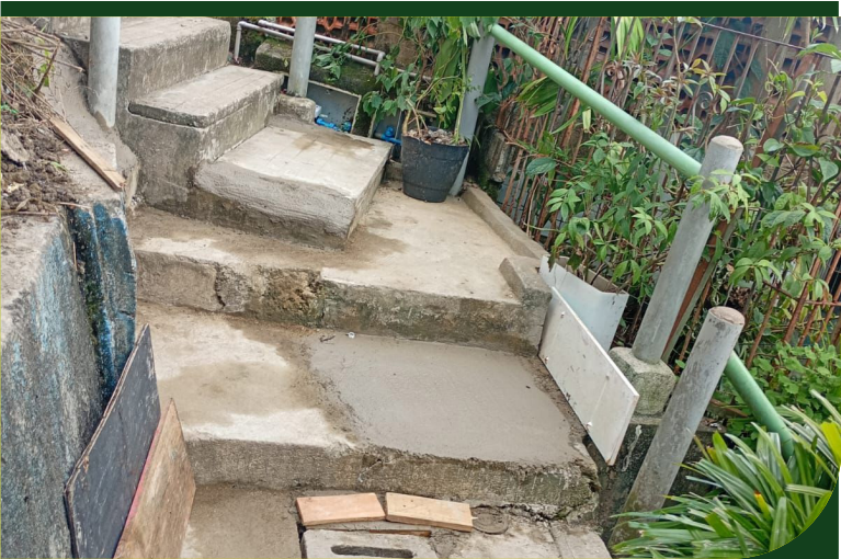
Reparo em tampas de grelhas de concreto na Rua Tiro Naval, próximo ao número 424, no Monte Serrat
