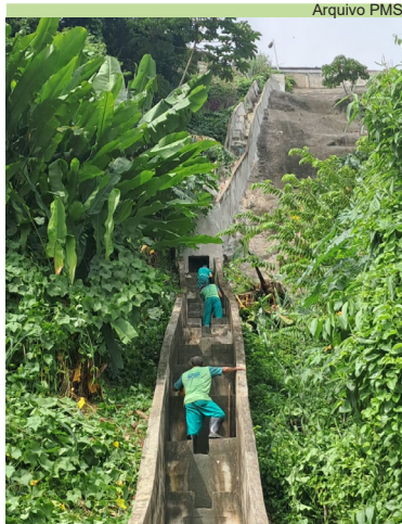
Serviço de limpeza da escada hidráulica no Complexo Marina Magalhães
