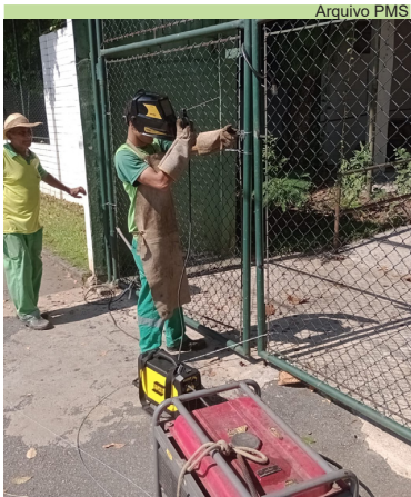
Realização de reparos no alambrado da Policlínica do bairro Rádio Clube
