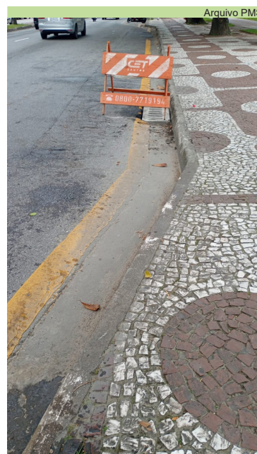
Troca de boca de lobo na Avenida Pres. Wilson, em frente ao número 36, sentido Divisa-Ponta da Praia
