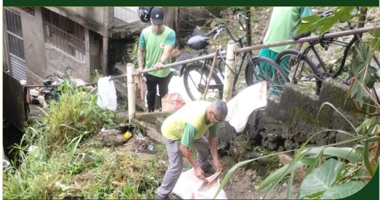
Manutenção em trincas da escada hidráulica na Rua Tiro Naval, próximo ao número 2318, no Monte Serrat
