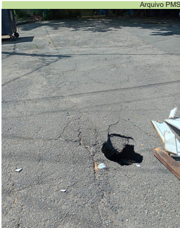
Manutenção asfáltica na Rua Maria dos Reis, no Morro Nova Cintra
