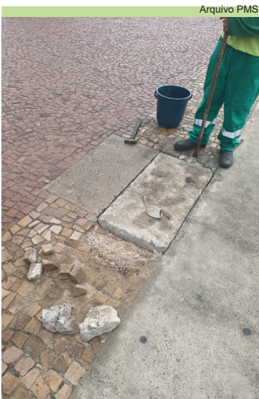
Reparo no piso mosaico no entorno do Museu do Surf, no Emissário Submarino
