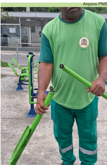
Reparo em equipamento da academia ao ar livre na Praça Champagnat, na Encruzilhada
