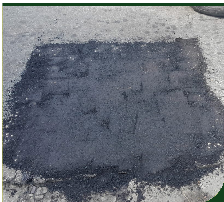
Manutenção asfáltica na Avenida Pinheiro Machado 302, no Jabaquara
