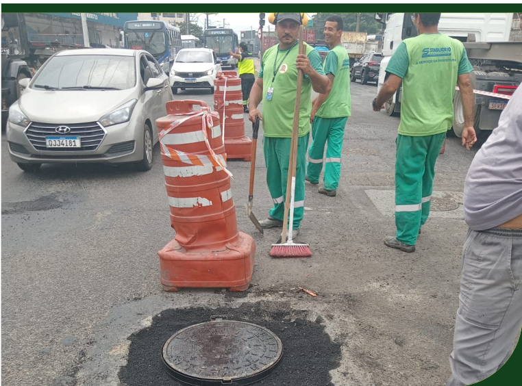
Substituição e renivelamento de poço de visita: Av. Nossa Senhora de Fátima com Rua Ana Santos
