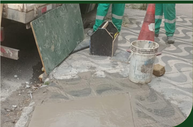
Concretagem de boca de sapo na esquina da Avenida dos Bancários com Rua Rei Alberto
