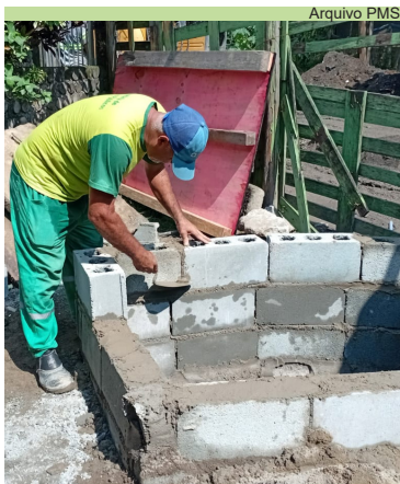
Vila dos Criadores ganha muretas de caixas de passagem para futuro aterramento
