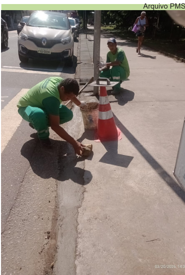
Trecho entre vias Epitácio Pessoa x Anália Franco ganhou reparo em rampa de acessibilidade
