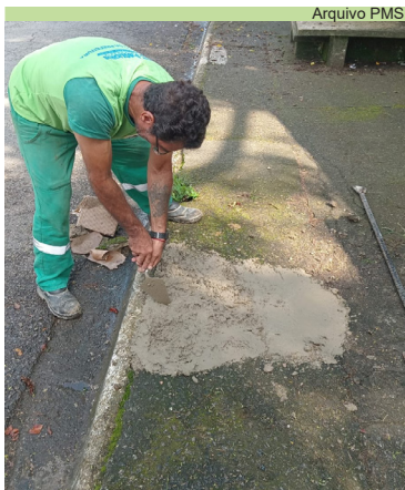
Finalizadas concretagem e instalação de tampa de concreto no Ilhéu Alto
