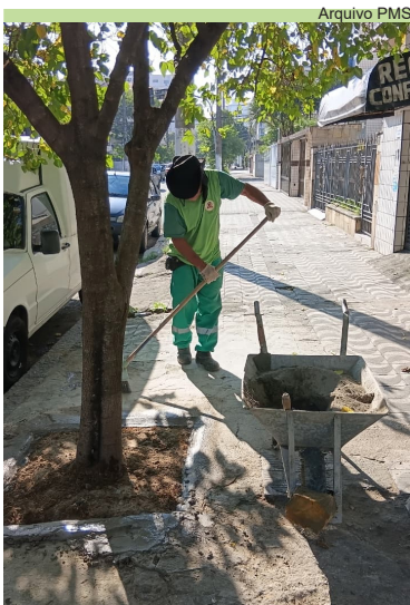
Equipe de zeladoria realizou reparo em calçada na Rua Pedro Américo, no Campo Grande
