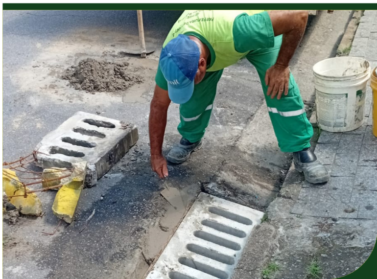
Reconstrução de caixa e substituição de boca de lobo na Rua Angelo Martins Melero, na Caneleira
