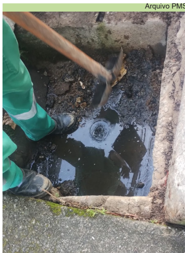
Limpeza de caixas na Rua Paulo Clemente Santini, no Nova Cintra
