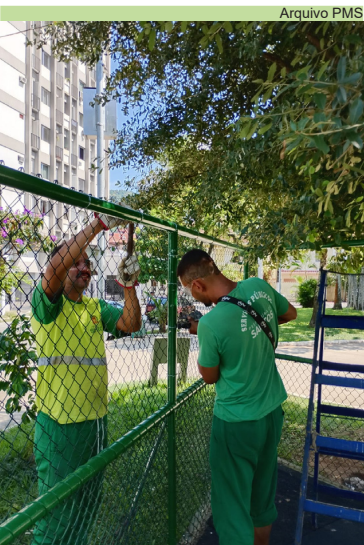
Instalação de tela no alambrado da Praça Olímpio Lima, na Vila Belmiro
