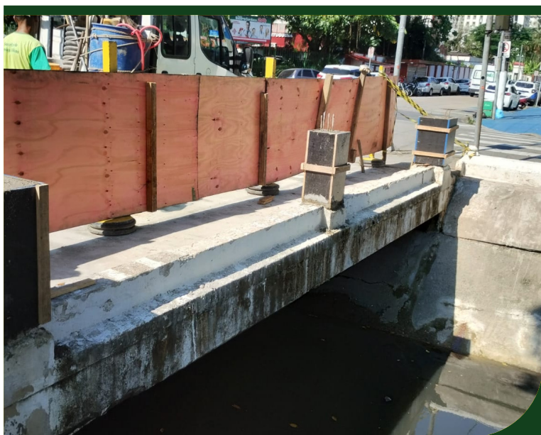
Reparo no guarda-corpo do canal 1, Avenida Bernardino de Campos, Vila Belmiro
