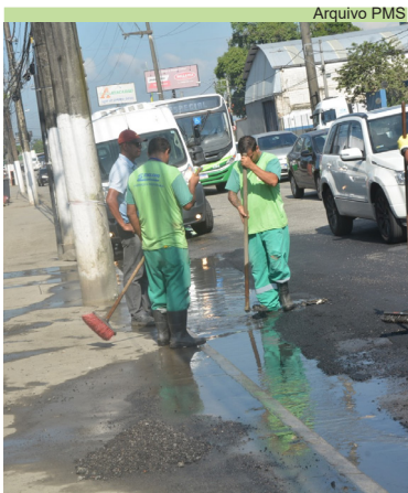
Serviço de limpeza e manutenção na Avenida Nossa Senhora de Fátima
