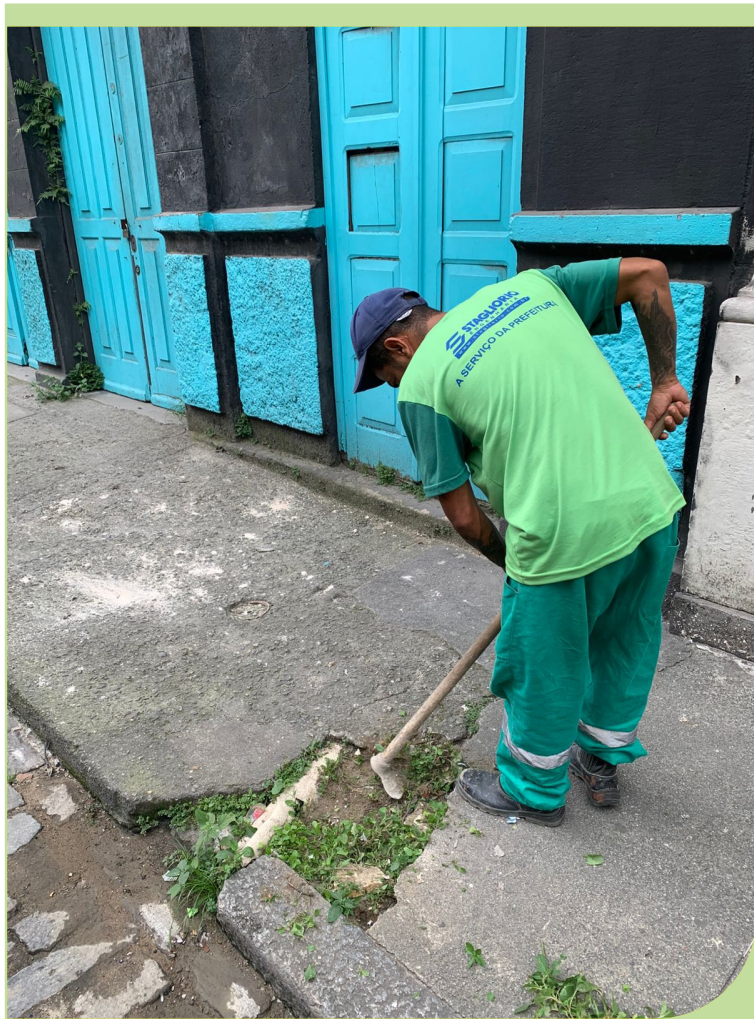
Manutenção na calçada na Rua José Ricardo, em frente ao número 30, no Centro
